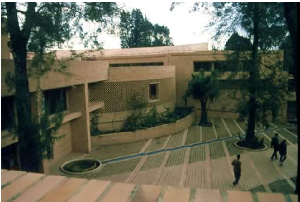
Acceso del edificio de Postgrados de la Universidad Nacional de Colombia. Arq. Rogelio Salmona.
