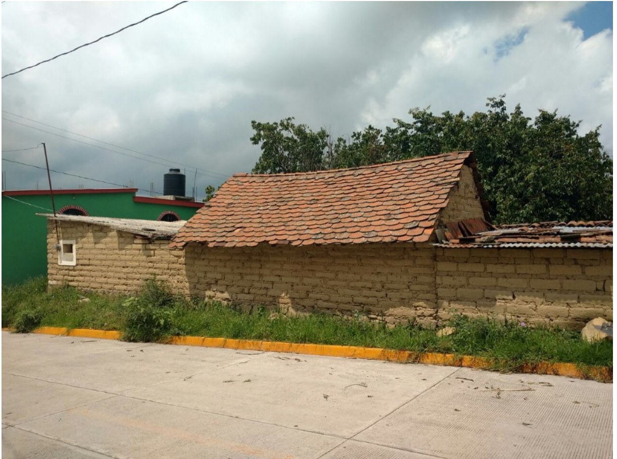
Conjunto de viviendas vernáculas. Tochimilco, Puebla.
