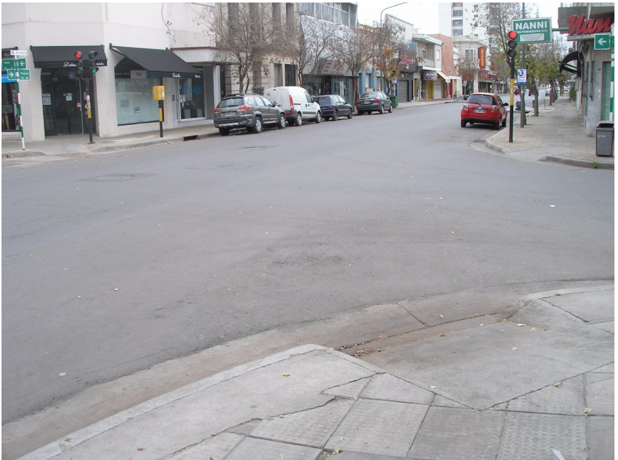
Las rampas mal direccionadas dirigen a los usuarios invidentes directamente al centro de la calle.
